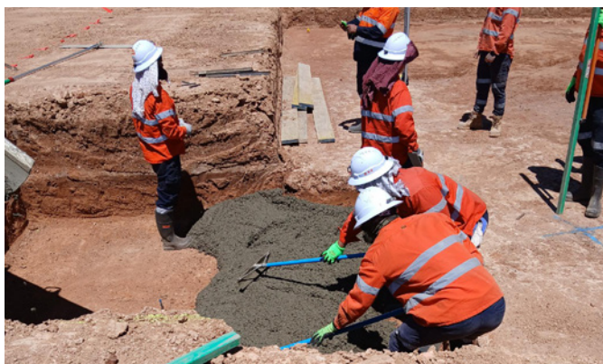
The first concrete pour at the Balranald site
